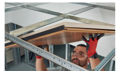
Plafón WoodWorks Channeled con plafón de relleno acústico Calla 2820 para un rendimiento acústico total
