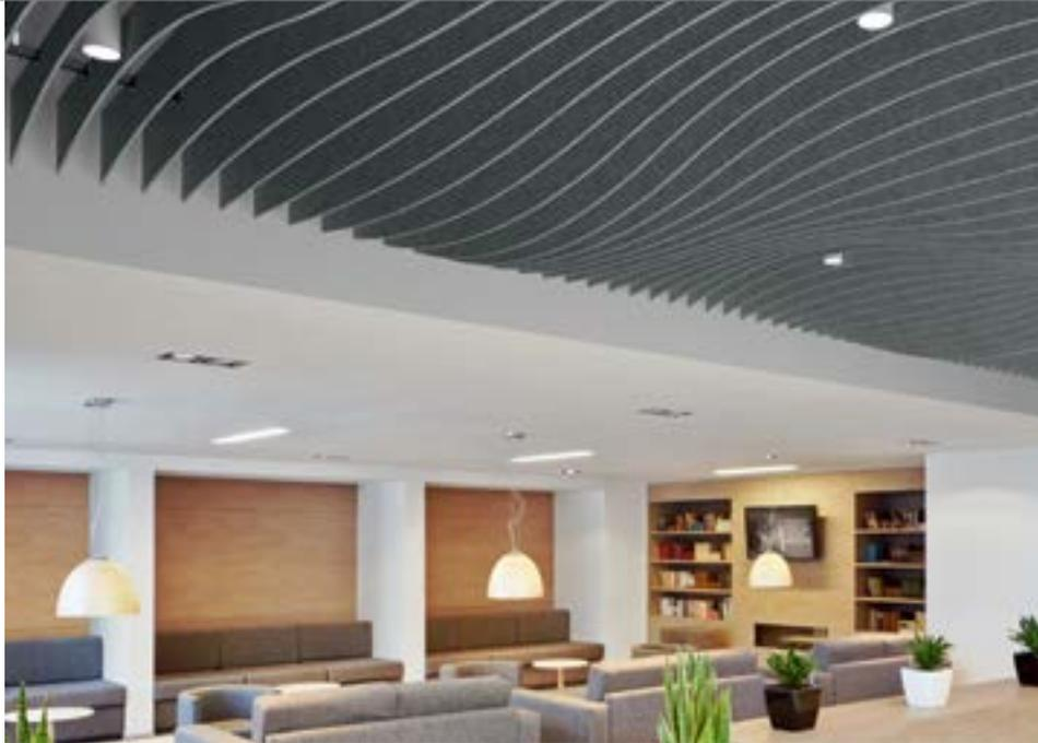
▲ Instalación con gancho del kit FeltWorks® Blades – HookOn Ebbs & Flows con separación de 4" entre las placas
