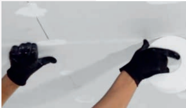
2. Pegue las juntas con cinta de malla de fibra de vidrio (cinta de papel para las esquinas).
