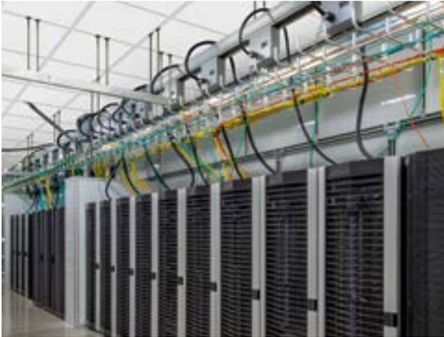
Compatible con el sistema de suspensión de aluminio estructural para centros de datos DynaMax®
