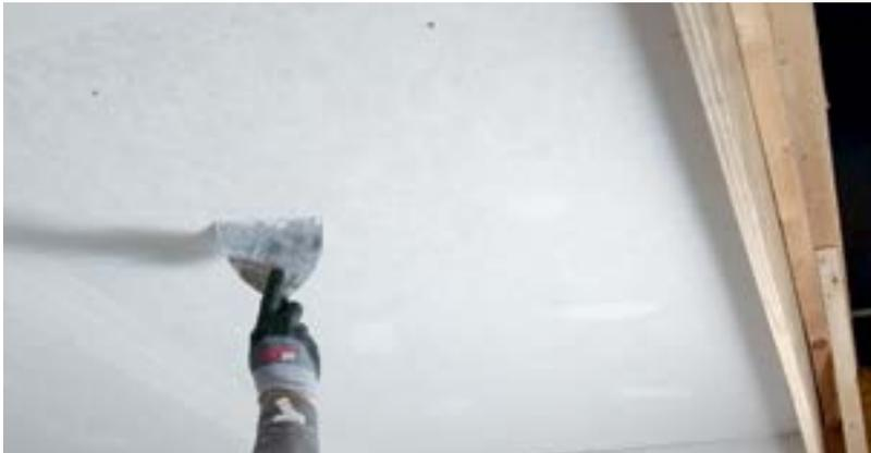
**3.** Una vez que el compuesto esté completamente seco, lije levemente las juntas y los rellenos sobre los tornillos con papel de lija de grano nro. 220 o uno más fino.
