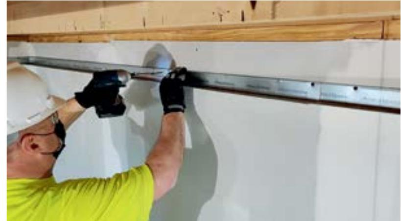
2. Instale las Tes principales del sistema de suspensión para panel de yeso (DGS, por sus siglas en inglés). Cuelgue las Tes principales 48" a eje con alambres de colgante 48" a eje y dentro de 24" del perímetro. Corte los extremos de las Tes principales en uno de los orificios de la ranura central para que las Te se puedan instalar a 16" de la pared.
