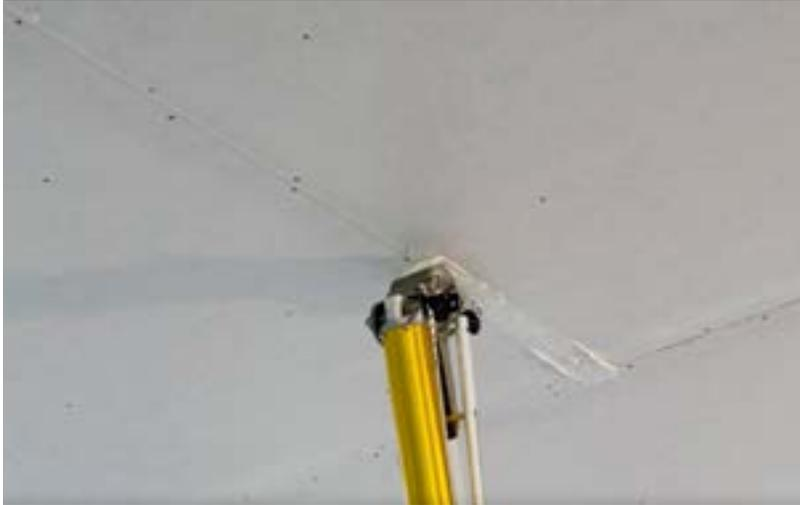
**2.** Rellene los tornillos de campo con un compuesto de fraguado rápido o un multiuso. Mantenga el área de acabado pequeña alrededor de cada tornillo. No cubra todos los tornillos con una sola franja de compuesto.
