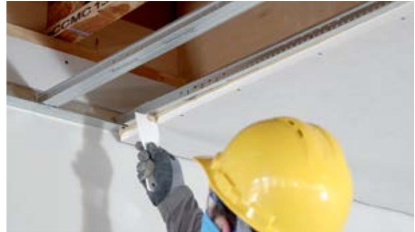
**8.** Para comenzar la segunda fila, agregue una Te adicional a 40" de la pared. Esta Te debe estar desplazada exactamente 32" más cerca del pared que la Te adicional que usó para comenzar la primera fila. Corte el nuevo plafón para terminar en el centro de la nueva Te e instálelo con adhesivo y tornillos como el plafón anterior.
