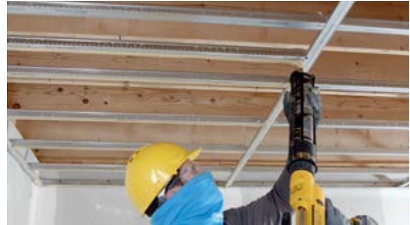
4. Instale el plafón en minutos, antes de que el adhesivo comience a secarse. Oriente el plafón de modo que la dimensión del largo sea paralela a las Tes principales. Alinee las orillas del plafón con las líneas centrales de las Tes principales y las Tes secundarias. Una vez colocado, presione el plafón firmemente contra el sistema de suspensión para establecer un fuerte contacto con el adhesivo.
