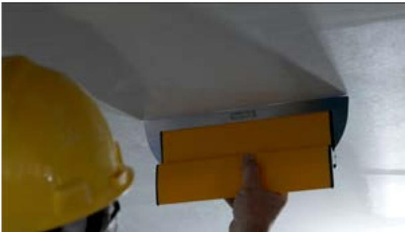
*La inspección en condiciones de iluminación críticas es fundamental para garantizar una instalación con acabado equivalente al Nivel 4 de alta calidad. Para mejores resultados, atenúe la luz de otras fuentes e inspeccione con una sola fuente de luz que ilumine a lo largo del nivel del plafón. La superficie debe estar lisa y libre de marcas de herramientas y crestas.*
