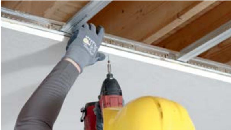
**6.** Introduzca aproximadamente 1/4" de cada tornillo a través de la cara del plafón. La cabeza del tornillo simplemente atravesará la capa de revestimiento del plafón para crear un pequeño orificio cuyo acabado se puede realizar fácilmente. Si no se atraviesa el entelado, la hendidura quedará más grande.
