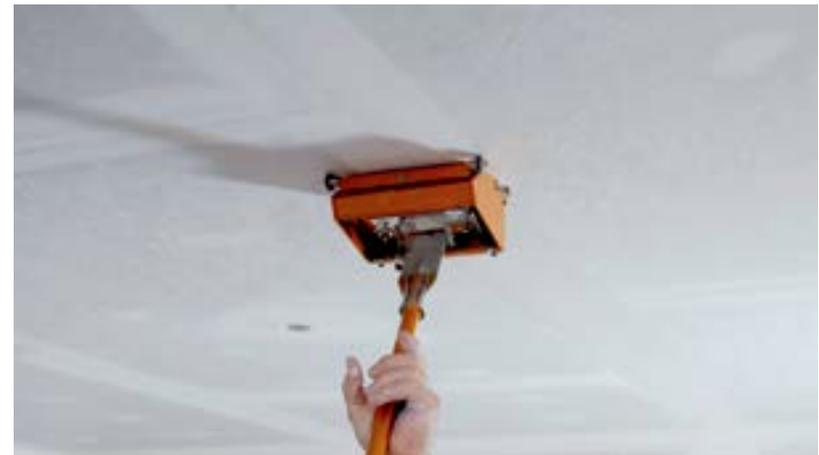
5. Después de que la capa anterior esté completamente seca, aplique la capa final de compuesto ligero ya mezclado a las juntas. Utilice una espátula o caja de 8". Realice el acabado de las juntas a no más de 8" de ancho para preservar el desempeño acústico. Según sea necesario, puede pasar una llana por las pestañas para mortero, como en los bordes para luminarias, para crear un aspecto plano. Si es necesario, rellene los tornillos por última vez.
