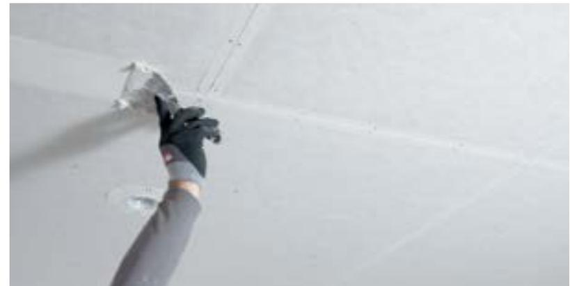
**1B.** Herramientas de encintado y acabado automáticos (ATF, por sus siglas en inglés): Primero llene los huecos o las áreas dañadas con un compuesto de fraguado rápido (mortero caliente) o un compuesto multiuso. De manera opcional, encinte las juntas con cinta Fibafuse® y compuesto multiuso premezclado con una herramienta de encintado y acabado automáticos Bazooka®. Use cinta de papel con compuesto multiuso premezclado solo en las esquinas. No use cinta de papel en las uniones lisas.
