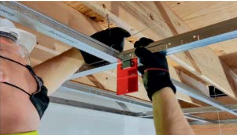
**5.** Encuadre el sistema de suspensión dentro de 1/8" sobre un módulo de 48" x 32". Fije las Tes secundarias perimetrales y las Tes principales a la KAM con tornillos para entramado.
