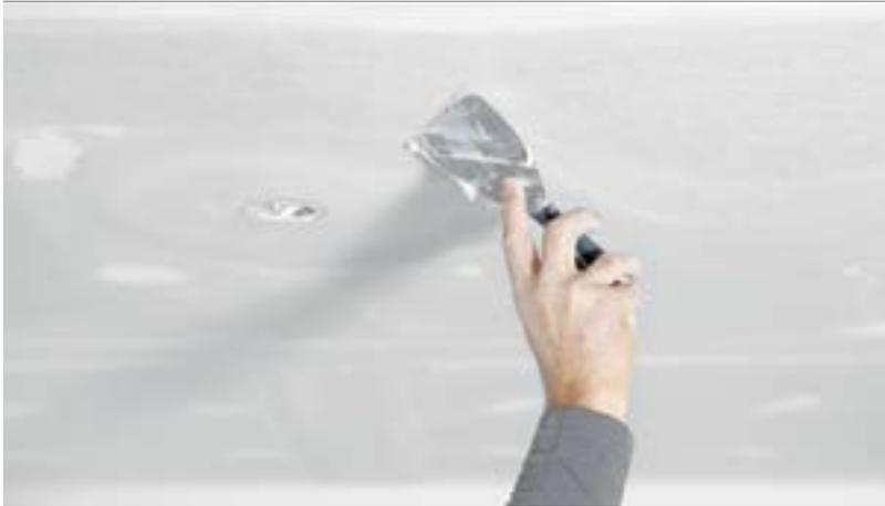
6. Cuando el compuesto esté seco, lije ligeramente las costuras y los rellenos con papel de lija de grano nro. 220. Si usa una lijadora eléctrica, comience con la configuración de velocidad más lenta y aplique una presión suave para evitar lijar la cara de los plafones. Lije (difumine) las orillas del compuesto para juntas a fin de eliminar toda rugosidad.
