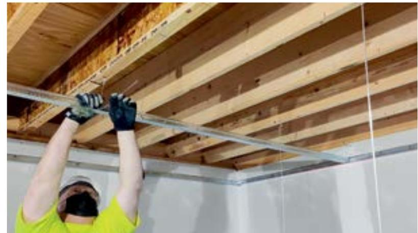
**3.** Instale las Tes secundarias de 48". Separe las Tes 16" a eje.
