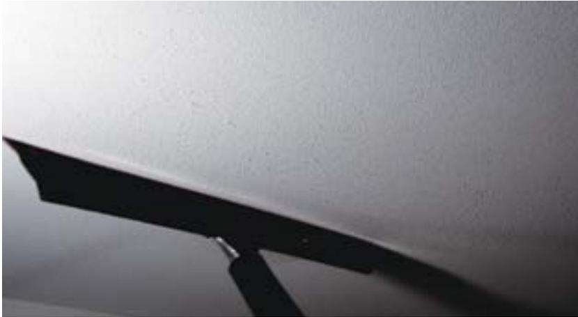
7. Cuando la cobertura sea uniforme y el acabado esté completamente seco, evalúe el aspecto final. Abra todas las ventanas para ver el cielo acústico en las condiciones de iluminación natural del lugar. Si es necesario, retoque las áreas claras con una capa adicional.
