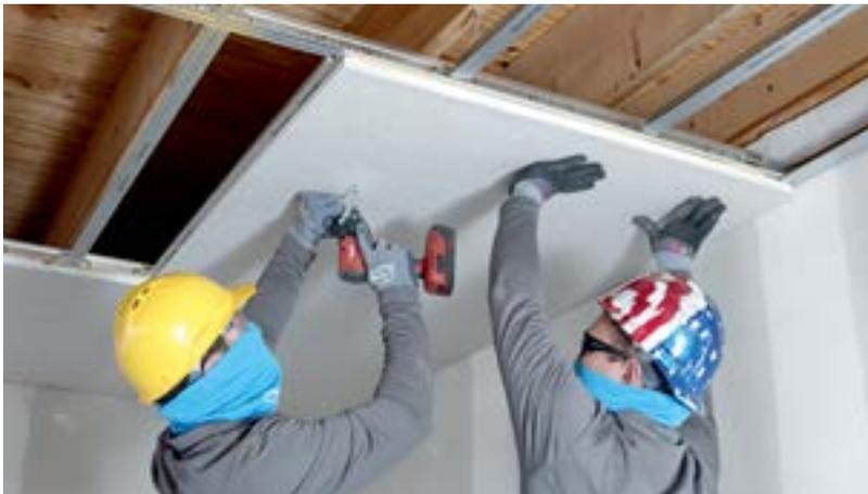
11. Corte las aberturas del plafón para MEP con una sierra de cerradura o un cortador giratorio. Aplique adhesivo y tornillos 8" a eje alrededor del perímetro completo de cada corte.
