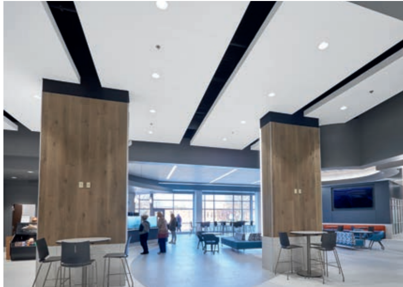
▲ Instalação de nuvem acústica AcoustiBuilt®; Universidade Vincennes, Vincennes, IN
