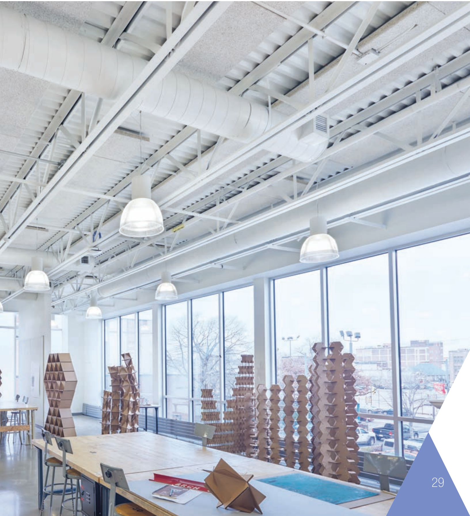
▼ Painéis Tectum® com fixação direta; Temple School of Architecture, Philadelphia, PA; NELSON, Philadelphia, PA
