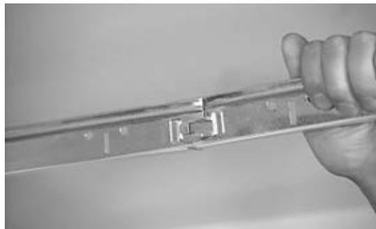
Adicione os tirantes e verifique o nível conforme prossegue com a instalação.
