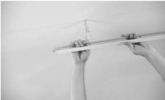
Instale a primeira seção dos perfis T principais (corte a extremidade de maneira que o orifício de fixação guia do perfil T secundário esteja colocado na distância igual da beirada desde a parede).
