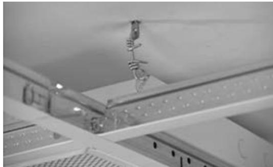
A suspensão pode requerer suspensores adicionais para suportar o peso dos artefatos de iluminação
