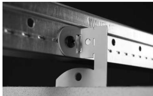
**OBSERVAÇÃO:** Para instalar os painéis Blades™ em um local onde o orifício de rota não está presente para aceitar a aba do clipe, use alicates de aviação para cortar a aba da ferragem embutida da ferragem embutida para que a ferragem restante possa ser pressionada firmemente contra o sistema de suspensão. Quando estiver alinhado, é só colocar um parafuso curto em cada orifício de conveniência do clipe no local desejado ao longo do componente do sistema de suspensão.
