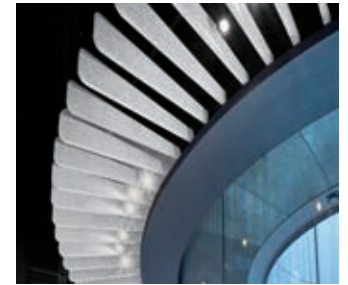
Tectum® Blades e Baffles painéis personalizados e instalados com vigas de aço personalizadas
