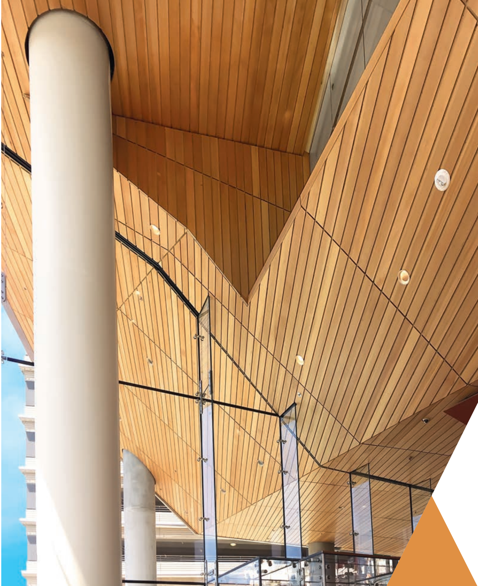
▲ Système de plafond linéaire WoodWorks™ ACGI; Tour FMC au Cira Center South, Philadelphie, PA
