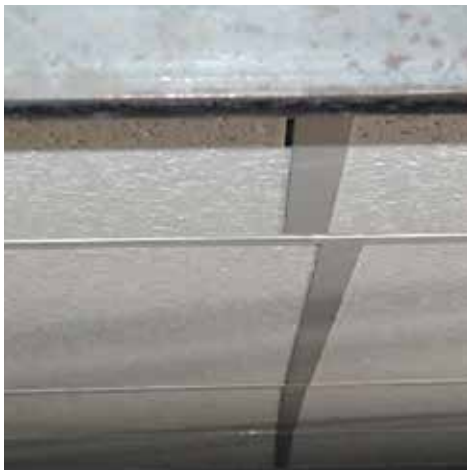
Les dommages aux raccords des tés croisés permettent le mouvement du plafond.
