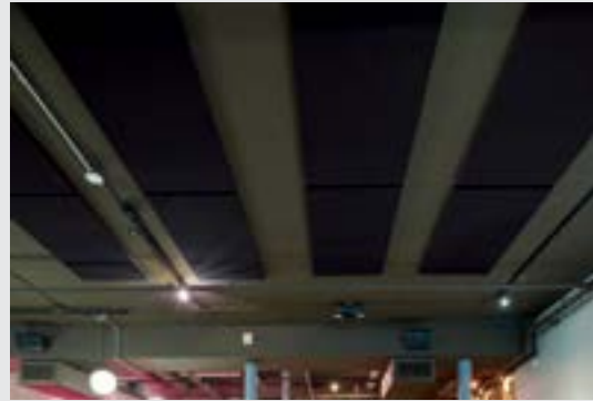
Panneaux dissimulés à l'intérieur de la structure
