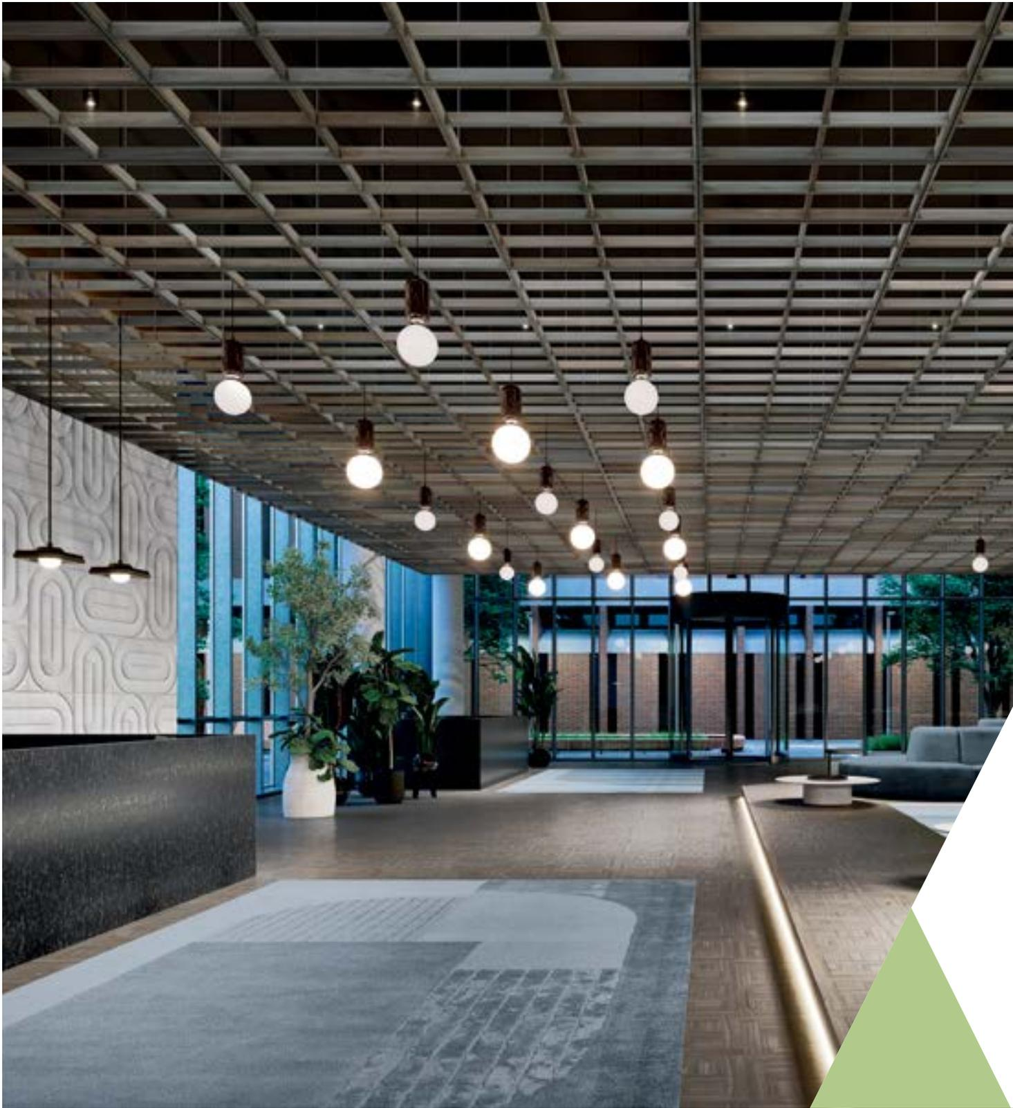
▲ Panneaux WoodWorks<sup>®</sup> à cellules ouvertes de 24 × 48 po en gris carbone, installation mur à mur
