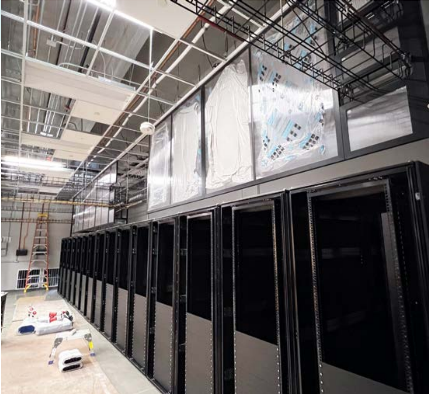
▲ Suspension structurelle DynaMax ™ avec système de confinement d'air intégré de Subzero Engineering
