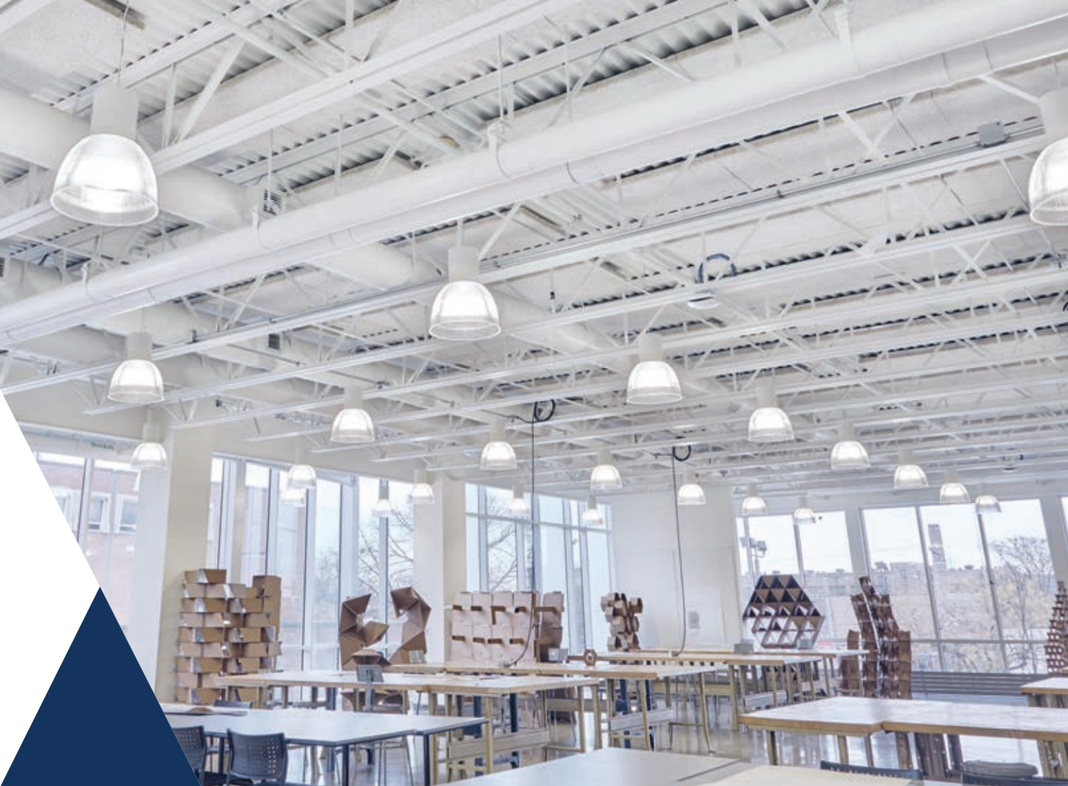
▲ Panneaux de plafond à fixation directe Tectum; Temple School of Architecture, Philadelphie, Pennsylvanie; NELSON, Philadelphie, Pennsylvanie
