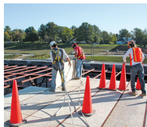
Installation de planche Tectum I avec béton isolant léger
