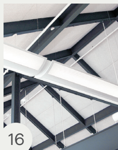
16 Panneaux de sous-toiture en composite Tectum
