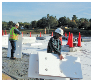
Installation de planche Tectum I avec béton isolant léger
