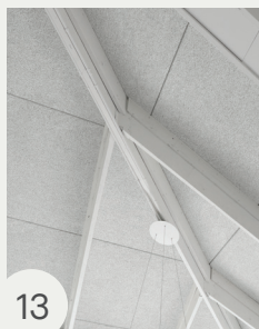
13 Panneaux de sous- toiture Tectum MD I
