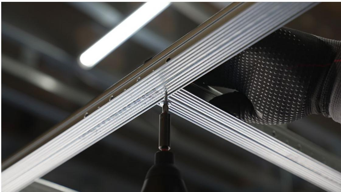
LANCASTER, Pa. – Les Solutions plafond et mur Armstrong a annoncé que ses tés croisés pour suspension à gypse FrameAll sont désormais offerts avec des semelles nervurées sur la longueur du té croisé. La nouvelle caractéristique augmente la saisie des vis et réduit leur sortie pendant l'installation d'un panneau.
