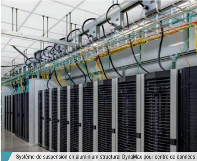
Système de suspension en aluminium structural DynaMax pour centre de données
