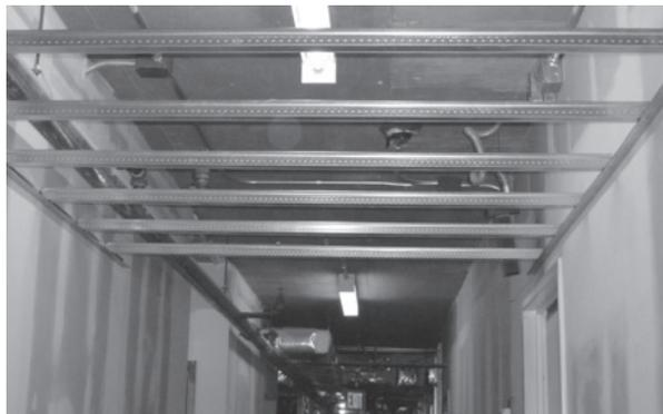
Le cadrage ShortSpan et la moulure à angle de blocage accélèrent et simplifient le cadrage pour panneau de gypse
