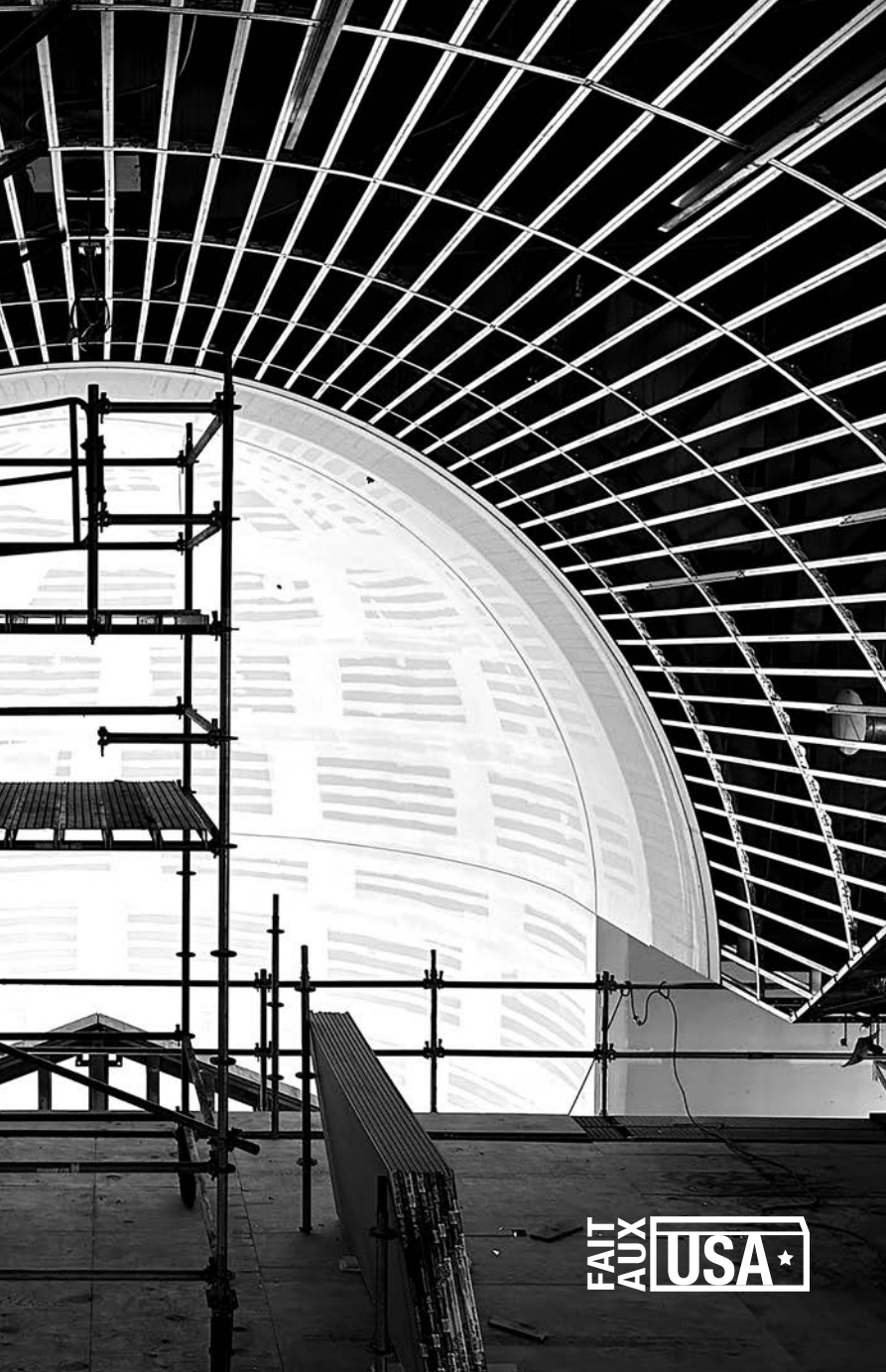
Installation de la voûte en berceau de la suspension pour gypse plat
