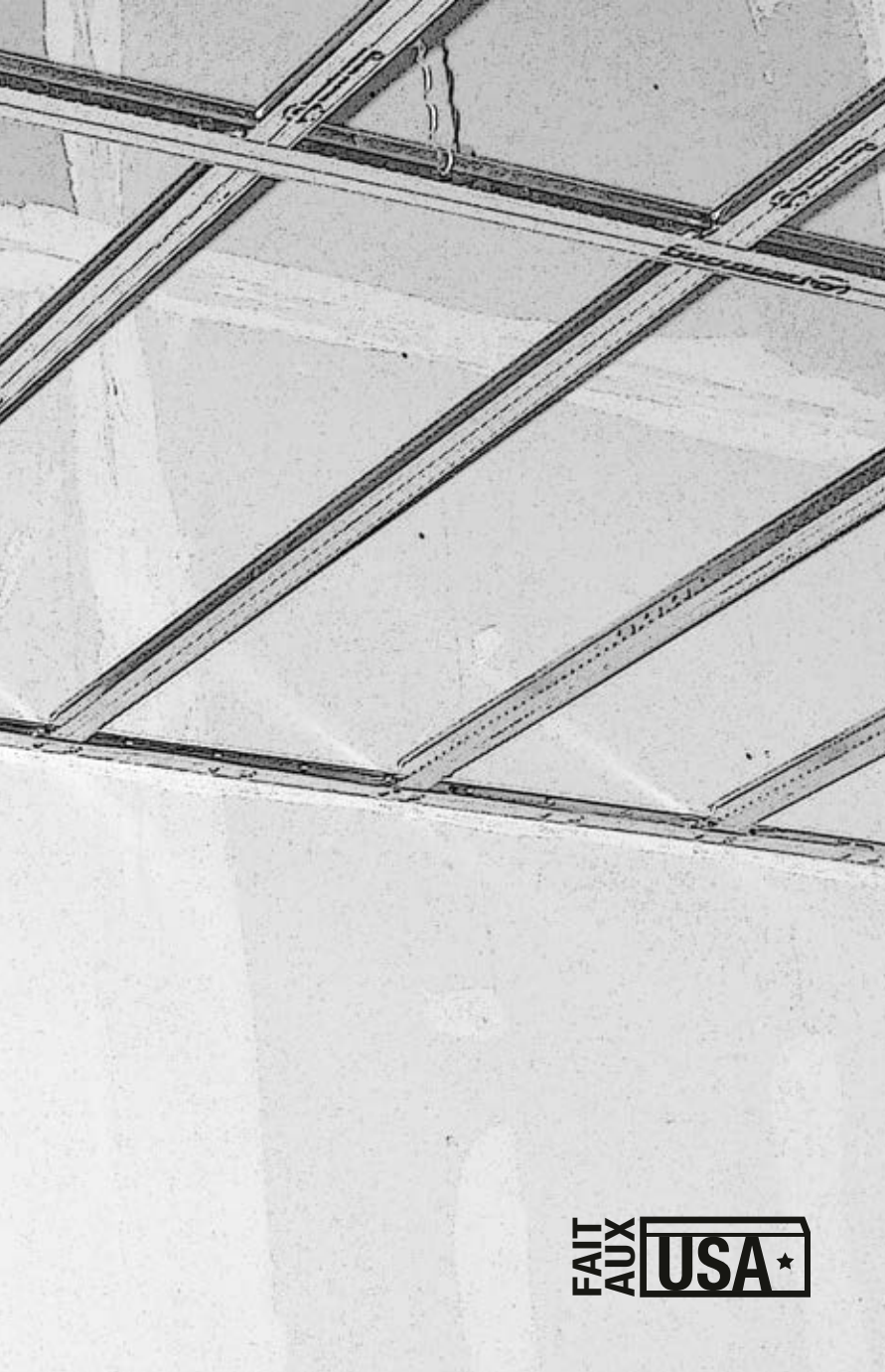
Installation de la suspension pour gypse plane
