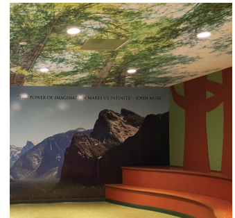
Panneaux Ultima MD Create! TM personnalisé avec système de suspension Prelude XL de 15/16 po
