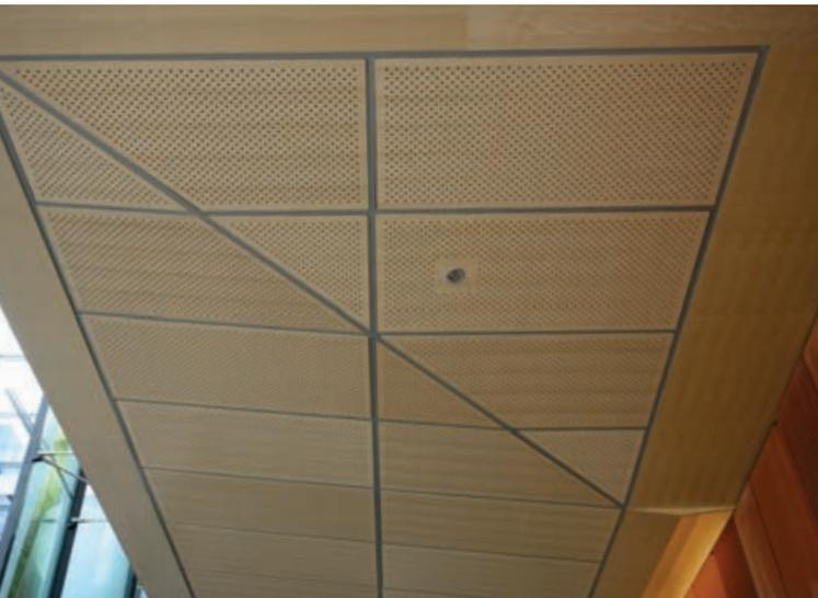
Le Panneau plat série 2 (SS2) est un panneau de plafond avec un rebord apparent. Le panneau repose sur une suspension Armstrong<sup>MD</sup> Prelude<sup>MD</sup> XL<sup>MD</sup> pour créer un retrait de 1 po entre les panneaux, ou une suspension Suprafine<sup>MD</sup> XL<sup>MD</sup> pour un retrait de 5/8 po. Les panneaux sont facilement détachables pour accéder au-dessus du plafond.
