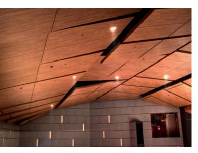
Le Panneau plat série 6 (SS6) est un système de plafond de grand format en pente. Chaque panneau est suspendu avec des supports de suspension d'Armstrong<sup>MO</sup> Prelude<sup>MO</sup> XL<sup>MO</sup> Suspension, CRS Channel ou Unistrut<sup>MO</sup> pour la suspension.
