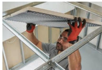
Panneau de plafond MetalWorks<sup>MC</sup> Mesh avec panneau de remplissage 2820BK Calla<sup>SM</sup> pour un haut CRB.
