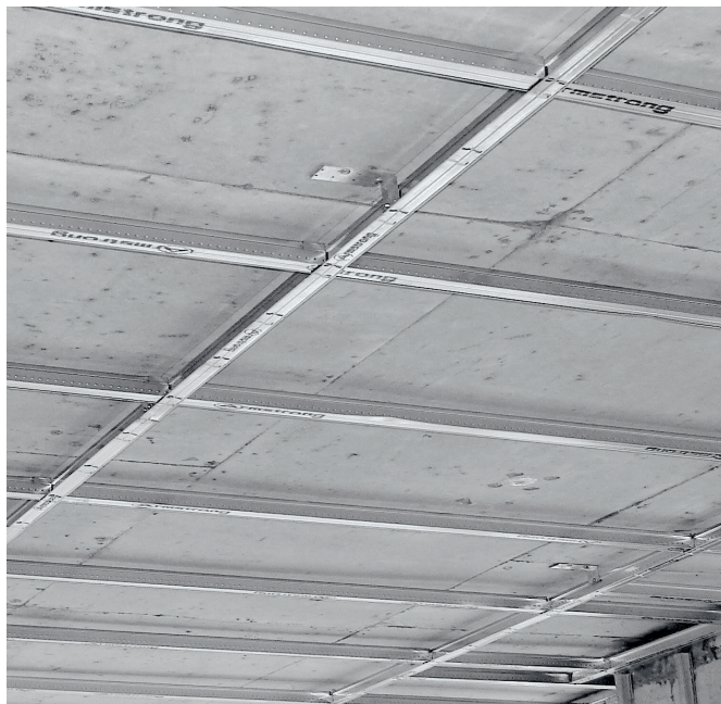
Système de suspension pour gypse QuikStix
