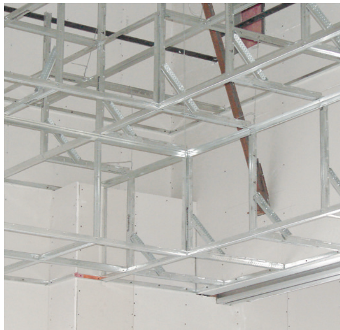
Système de suspension pour gypse QuikStix MC pour retombées
