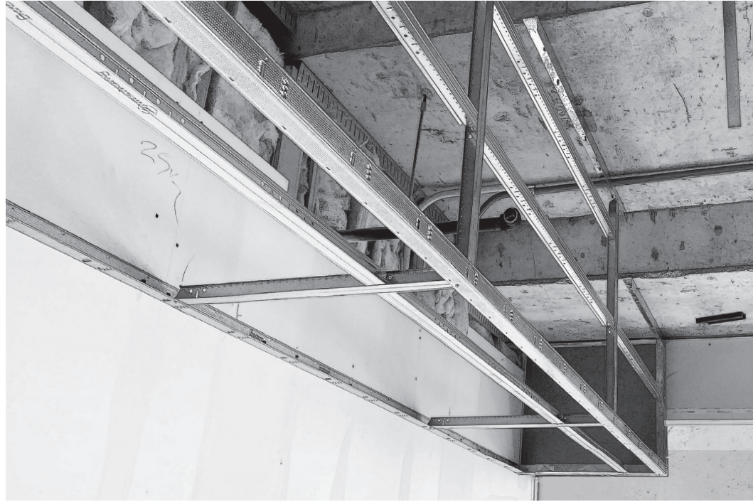
▲ Système de cadrage pour retombée de plafond en gypse SimpleSoffit
