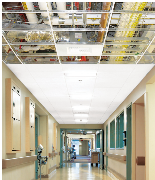
▲ Le système SingleSpan peut contribuer à éliminer les fils de suspension
