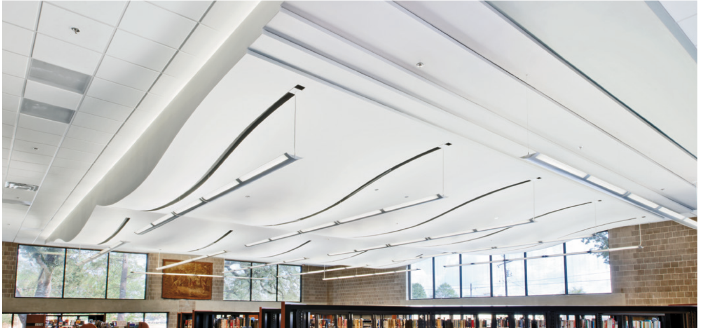
▲ Système de treillis pour gypse à facettes pour plafonds de gypse courbés
