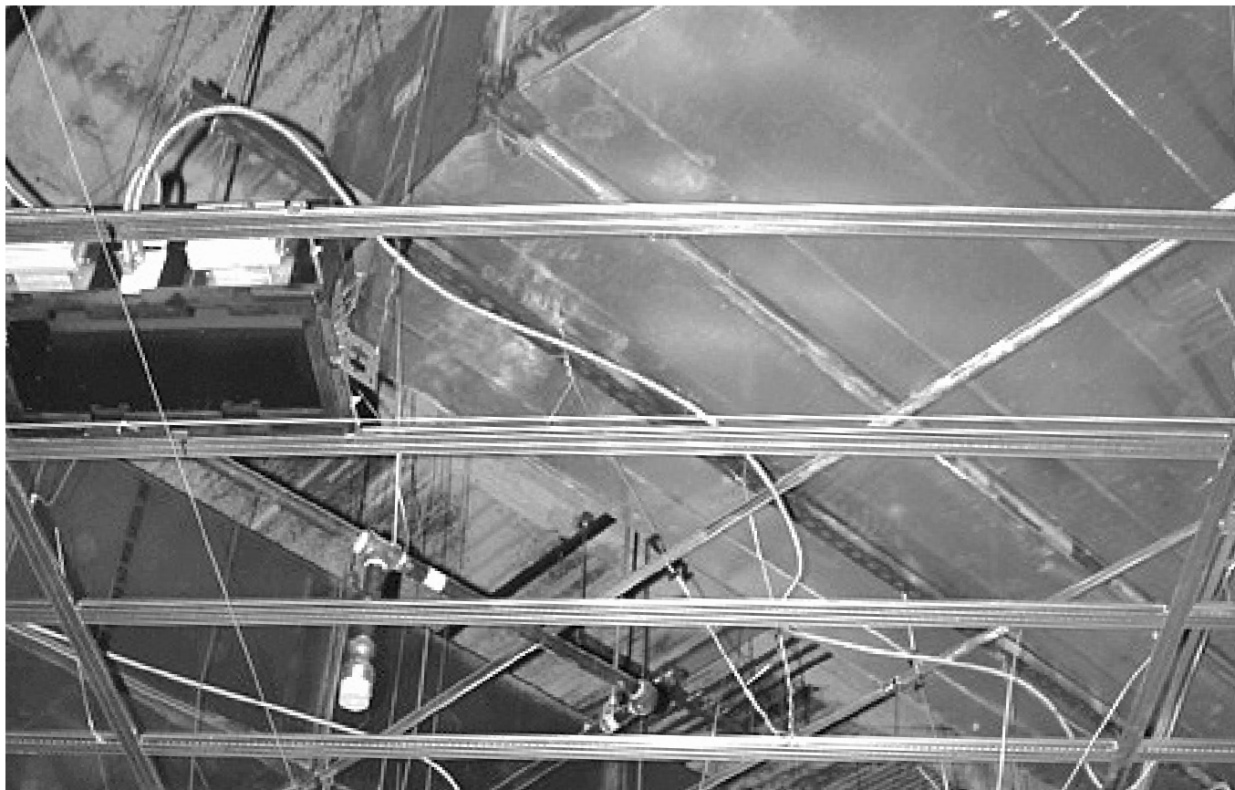
Système de suspension FrameAll avec le té croisé 6 pi XL8965
