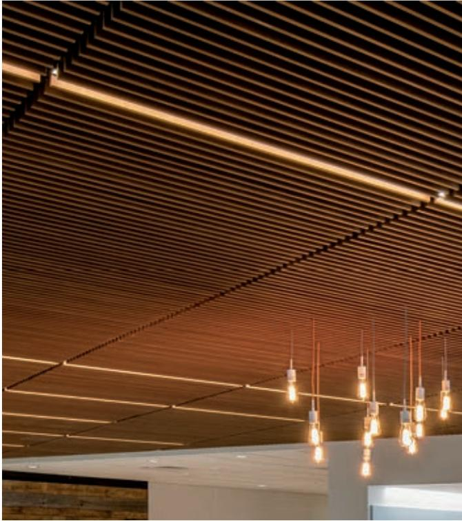
▲ WoodWorks Grille tégulaire avec lentille de diffusion T-BAR LED JLC-Tech
