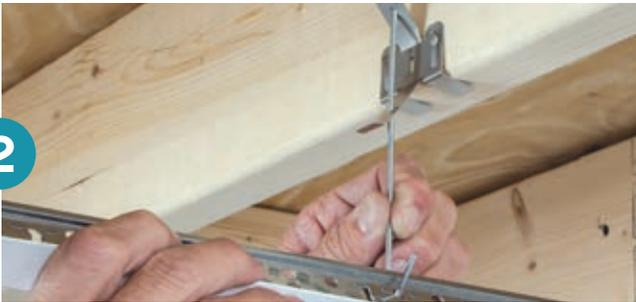
Suspenda las tes principales con alambre de colgante o los accesorios de sujeción\* QuickHang™ (se muestran más arriba: ganchos y soportes QuickHang)
