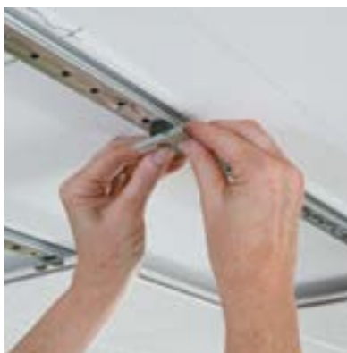
2 Fixez les attaches (modèles 1191 ou 1191SC)
