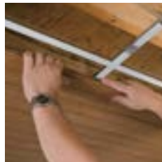
Positionnez les planches; faites glisser et fixez les attaches
