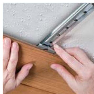
Pose des planches WoodHaven MC à l'aide des rails et des attaches Easy Up MD
