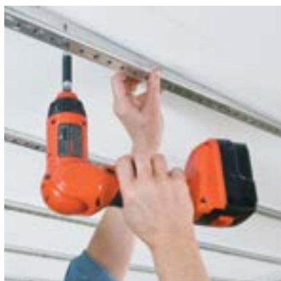
1 Attachez les rails (modèle 1190)
