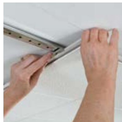
3 Positionnez le carreau ou la planche; faites glisser l'attache et fixez-la
