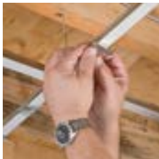
Fixez les attaches Easy Up
