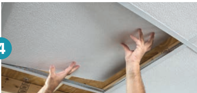
4 Installez les panneaux de plafond
