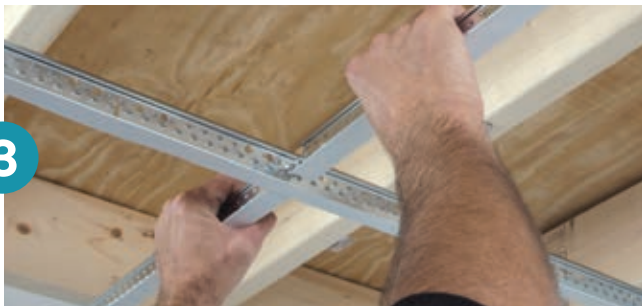
3 Installez les tés croisés
