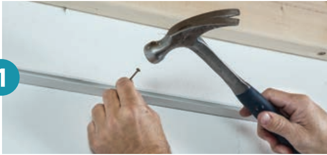
1 Installation de la moulure murale
